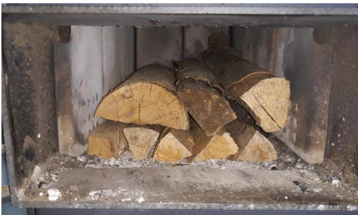
4. Nun kann die Brennkammer nach oben mit größeren Scheithölzern möglichst Luftdicht vollgeschichtet werden. Dabei sollten die Größten Scheite nach oben gelegt werden! Der Querschnitt der Scheite muss der Breite des Brennraumes angepasst werden. Um eventuelle Höhlbrände durch „verkanten“ zu vermeiden wird empfohlen, die Breite so zu wählen, dass mind. 3 Scheithölzer nebeneinander passen.
